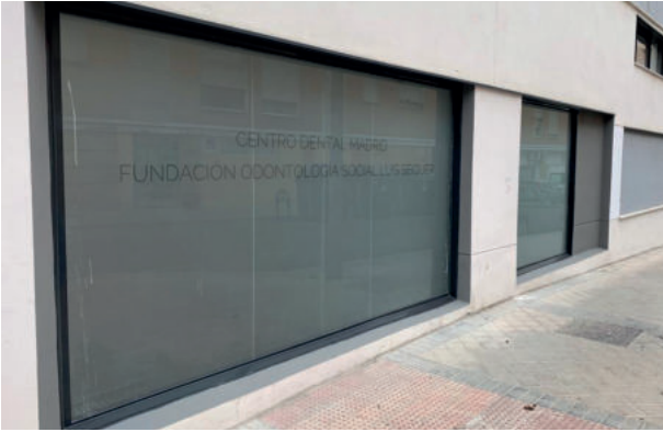
Exterior de la nueva clínica en Madrid.
